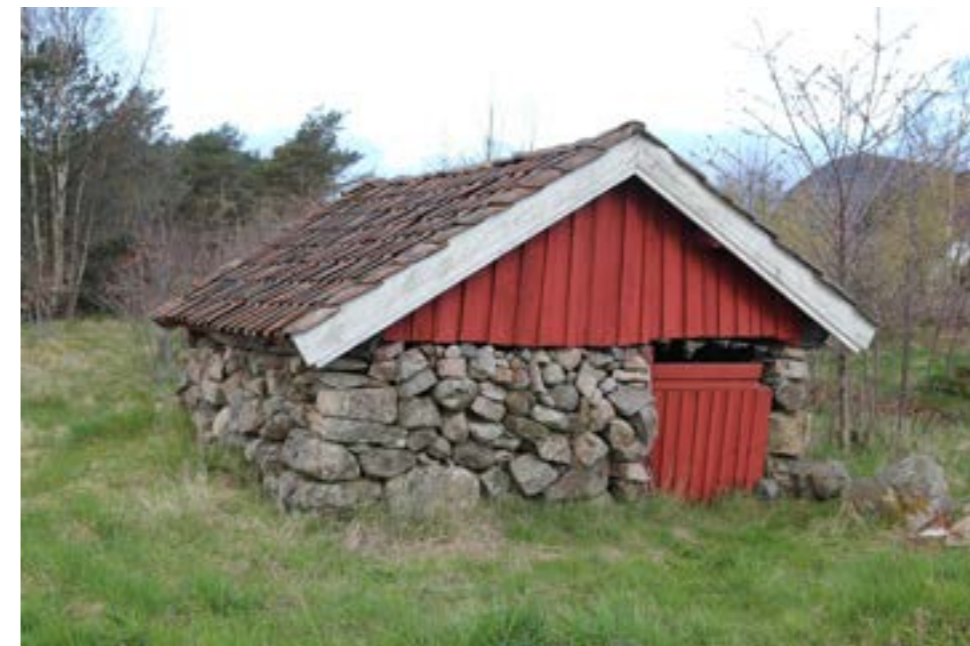
Sommerfjøs i Spangereid, tilhørende gården Presthus. Sommerfjøs, også kalt sommerflorer, var frittstående bygninger til å ha krøtter i om natta. Sefrak 14-097.
