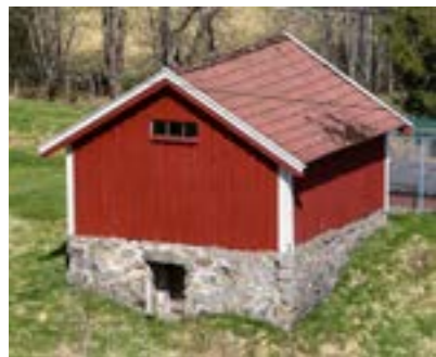
En unik kombinasjon i Lindesnes. Potetkjeller som faktisk er en kjeller på en vedbod. Den står på Tveida i Vestbygda, og er datert til 1800-tallet.
